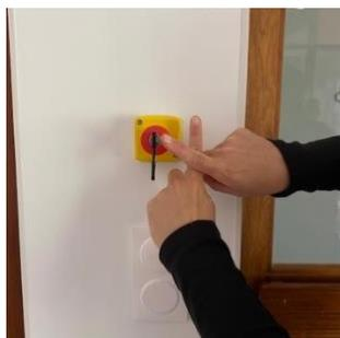
Si par inadvertance quelqu'un a appuyé sur le bouton jaune et rouge d'arrêt d'urgence dans le hall d'entrée, il faut remettre le disjoncteur.
